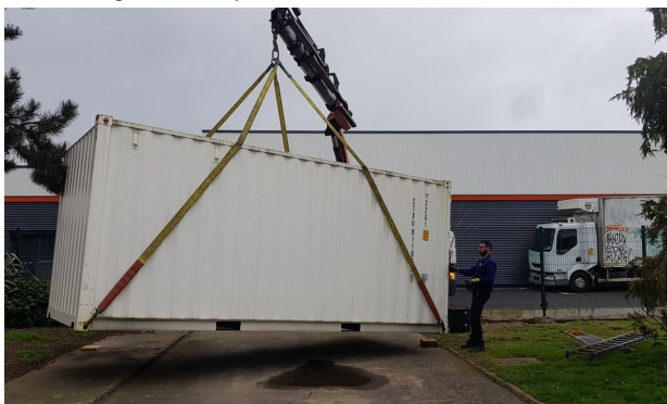
Installation d'un container - février 2022
