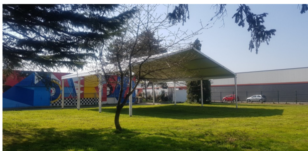
Installation du chapiteau - mars 2022
